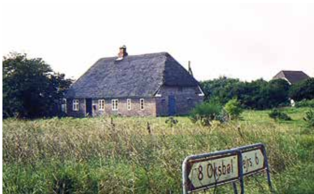
Grærup. Peder Jacobsens gård i Grærup. Bygningen findes i Kaj Gottlobs registrant, og ligger der stadig, som et godt eksempel på, at Forsvaret har taget sit ansvar for området alvorligt. Foto: Frode Jensen.
