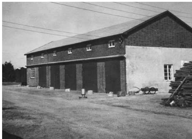
Garageanlægget er en anden af de få bygninger fra Værnemagts tid, der har overlevet til i dag. I C.A.-lejren udgjorde bygningen rammen om de skiftende værkstedshold. Se billedet side 138. Foto: Max Martner.
