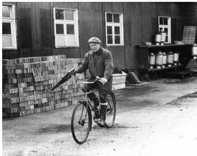
Arbejdsleder Søren Grønfeldt på vej i felten. Til venstre ses nogle af de 15 millioner mursten. Foto: Verner Hansen, ca. 1955.
