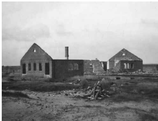
En tidligere køkkenbarak i Oksbøllejren under nedbrydning. Foto: Aage Hansen, ca. 1951.
