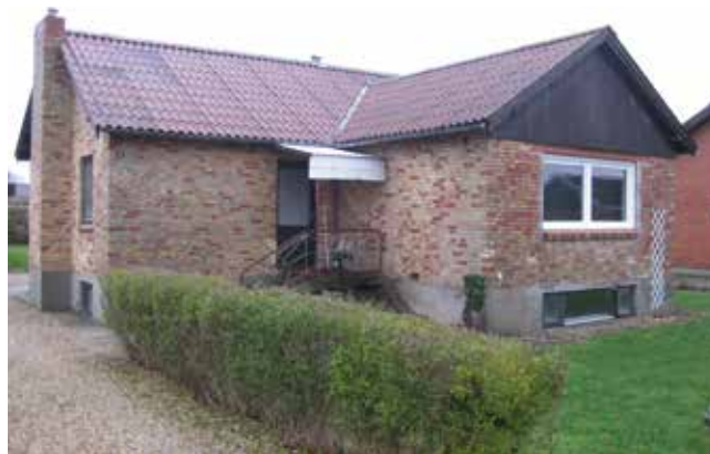
Elmevej 9 i Oksbøl skal angiveligt være bygget af sten købt i Oksbøllejren, hvilket murværket med de blandede røde og gule sten også synes at bekræfte. Foruden parcelhuse blev materialerne også solgt og genanvendt til stalde, lader og sommerhuse.
