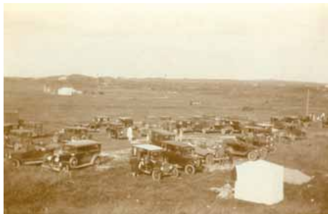
Hennehus med serveringstelt i baggrunden, 1928-1929. Foto: Privateje.
