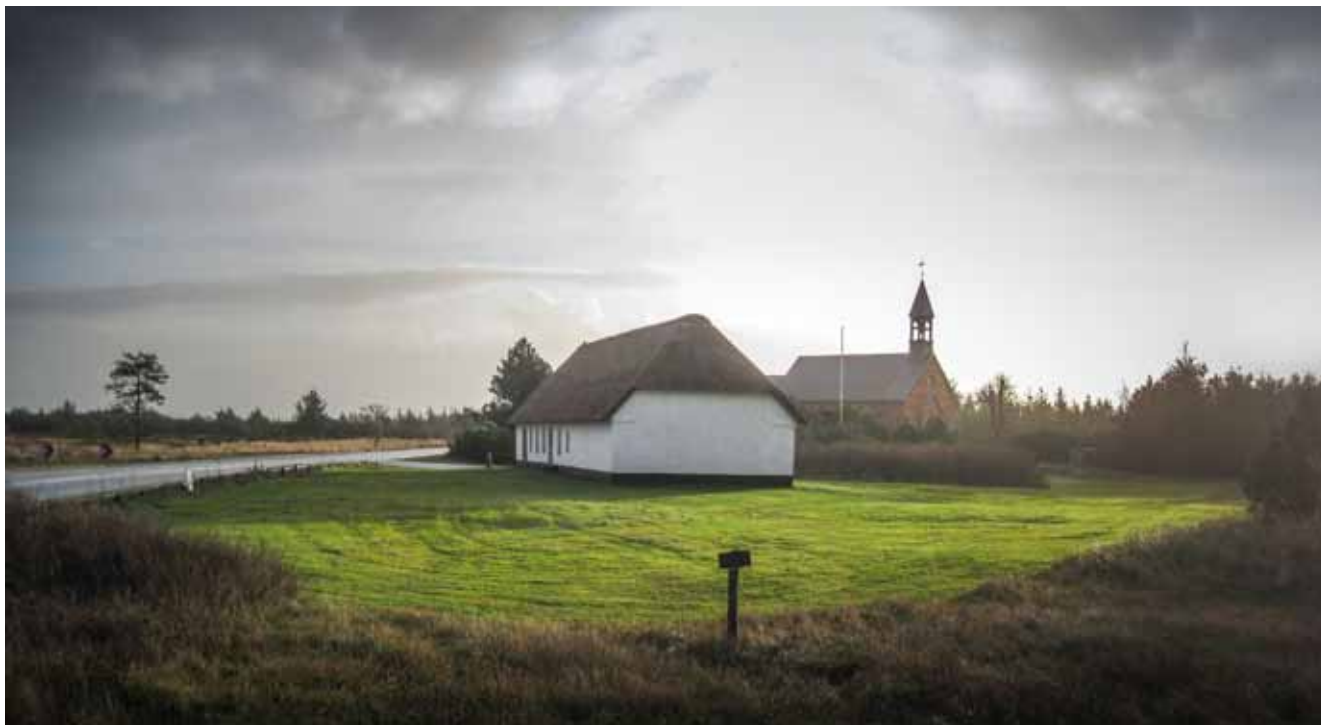
Et godt eksempel på, hvorledes Forsvaret har renoveret naboejendommen til Mosevrå kirke. Huset er blot en skal, med påmalede vinduer, men det klæder både landskabet og kirken. Havde man i stedet valgt at fjerne huset havde det bidraget til at gøre landskabet mere øde og goldt. Lokaltiteten passeres i sommerhalvåret af i titusindvis af sommergæster.
