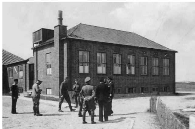
Blåvand Radio opført i 1938. På billedet ses flakstillingen (anti-luftskyts) på taget. Flakstillingen blev opstillet i marts 1941.
