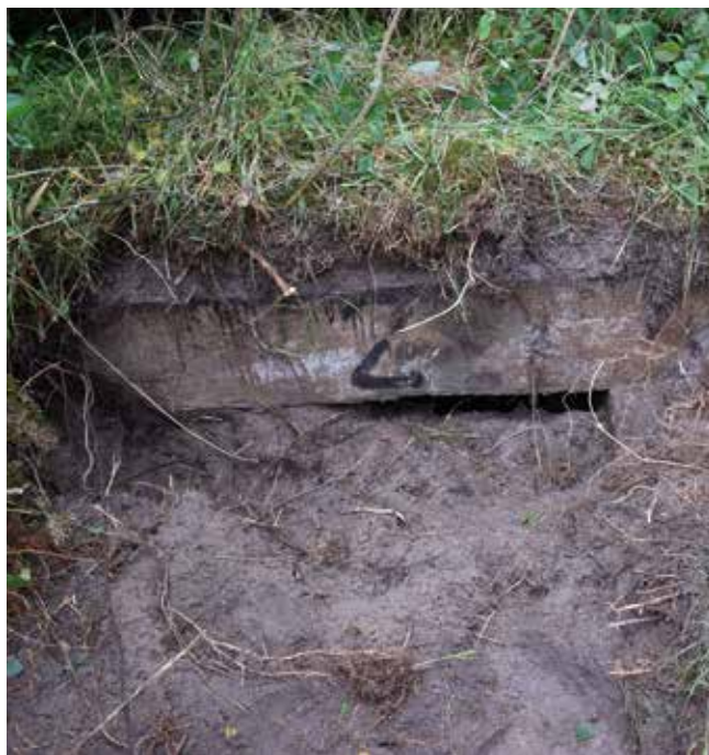
Bunkerens indgang var helt skjult af bevoksning, og efter at have fjernet et par tørv kunne vi konstatere, at den også var fyldt med sand.
